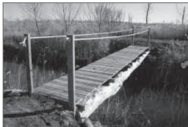
Puente de madera.
