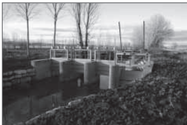
Nuevas compuertas de la laguna.
