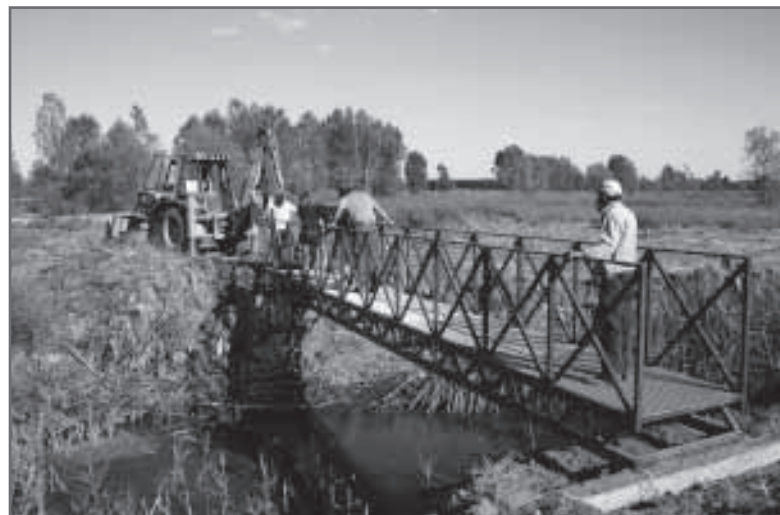
Colocación de la pasarela de hierro sobre la hila del Raidal.
