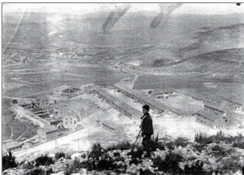
Dos instantáneas de la vida que hubo en las instalaciones.
